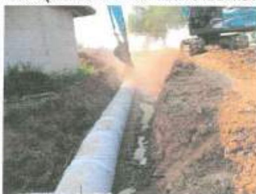
๒๒. ปรับปรุงวางท่อระบายน้ำ คสล. บ้านบะทองใหม่ หมู่๑๒
