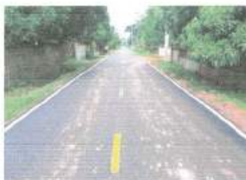
๓๑.โครงการปรับปรุงผิวถนนคอนกรีตเสริมเหล็ก โดยวิธี Overlay สายบ้านนาหัวช้าง-บ้านบะทองนาหัวช้าง หมู่ ๙
