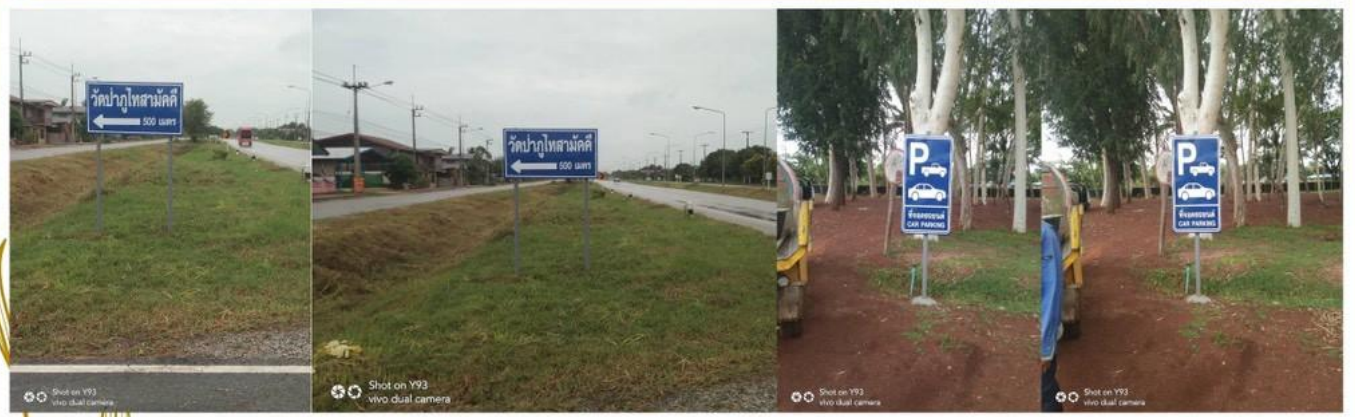
ทีมงานกองช่าง ทำการติดตั้งป้ายบอกทางเข้าวัดป่าภูโหลวมคคี และป้ายจอดรถ ที่พิพิธภัณฑสถานพระอาจารย์ฝั้น อาจาโร
