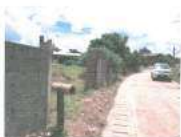
ดำเนินการแล้วเสร็จ
