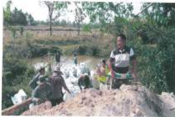
๒๒.โครงการก่อสร้างฝายชะลอน้ำ (ฝายกระสอบ)
