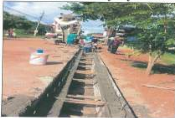
๓๔.โครงการก่อสร้างวางระบายน้ำรูปตัวยู ขอบฝั่งขวาทางหลวงท้องถิ่น หมายเลข สน.ถ.๑๐๒-๐๑
