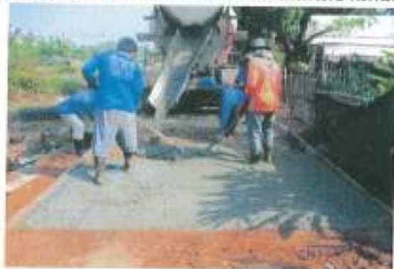
๓๑.โครงการก่อสร้างต่อเติมถนนคอนกรีตเสริมเหล็กบ้านหนองแขง หมู่ ๑๑ (สายหน้าบ้านนายธง จอมสีวันา)
