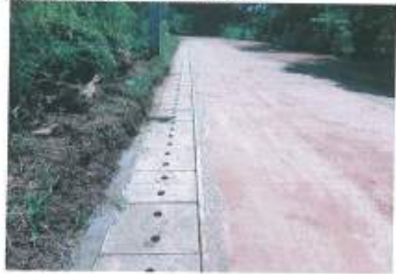
๓๓.โครงการก่อสร้างวางระบายน้ำด้วย ขอบฝั่งซ้ายทางหลวงท้องถิ่น หมายเลข สน.ถ.๑๐๒-๐๑
