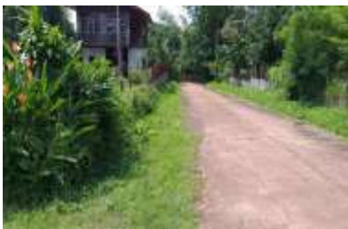
๓๖. ก่อสร้างวางระบายน้ำรูปตัวยู บ้านน้อยโนนจันทน์ หมู่ ๑๐
