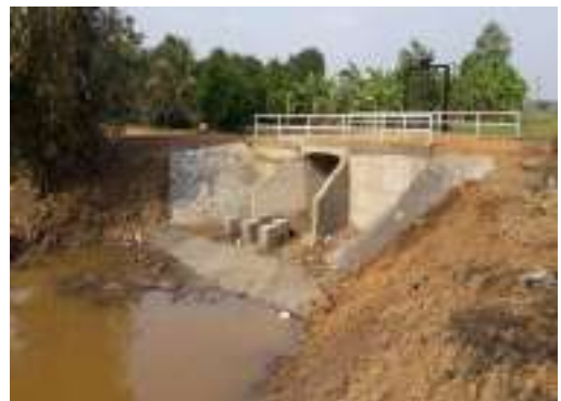
๒๔. ก่อสร้างท่อลอดเหลี่ยมพร้อมติดตั้งประตูระบายทน้ำ บ้านพรณา หมู่ ๒
