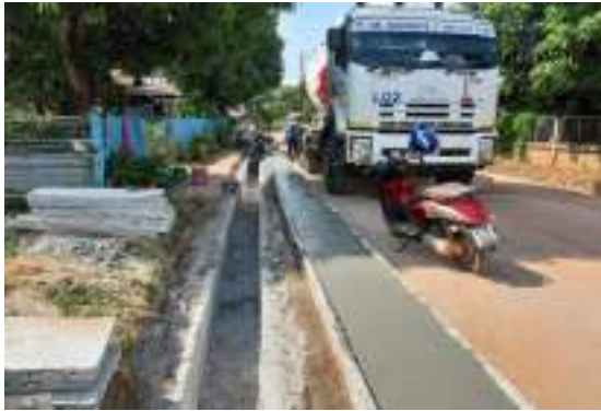
๓๔.โครงการก่อสร้างรางระบายน้ำรูปตัวยู ขอบฝั่งขวาทางหลวงท้องถิ่น หมายเลข สน.ถ.๑๐๒-๐๑
