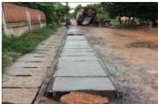
๓๒.โครงการก่อสร้างรางระบายน้ำ คสล.รูปตัวยู บ้านม่วงไข่ หมู่๑ (สายหน้าบ้านนายประเทิน นามอิราฯ)
