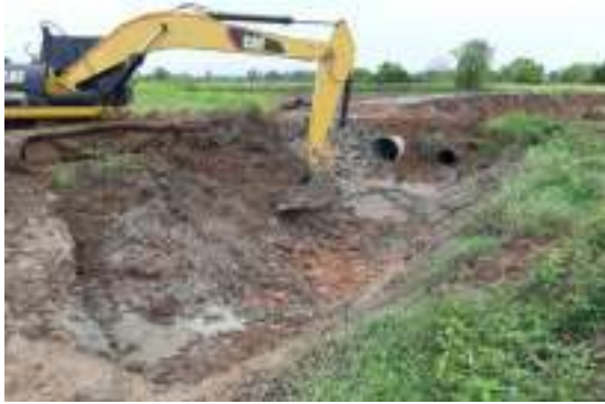
๒๖.โครงการเพิ่มศักยภาพแหล่งน้ำต้นทุนด้วยระบบธนาคารน้ำใต้ดิน(Ground Water Bank)
