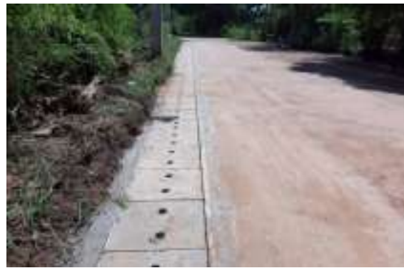
๓๔.โครงการก่อสร้างรางระบายน้ำรูปตัวยู ขอบฝั่งขวาทางหลวงท้องถิ่น หมายเลข สน.ถ.๑๐๒-๐๑
