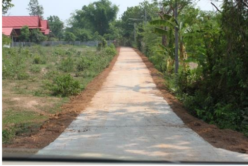
17. ก่อสร้างถนนคอนกรีตเสริมเหล็ก บ้านหนองอ้อ หมู่ 13
