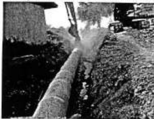
๒๒. ปรับปรุงวางท่อระบายน้ำ คล. บ้านหนองใหม่ หมู่๑๒
