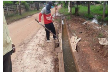
ก่อสร้างรางระบายน้ำรูปตัวยู บ้านโคกสุวรรณ หมู่ ๖ ก่อนดำเนินการ ระหว่างดำเนินการ
